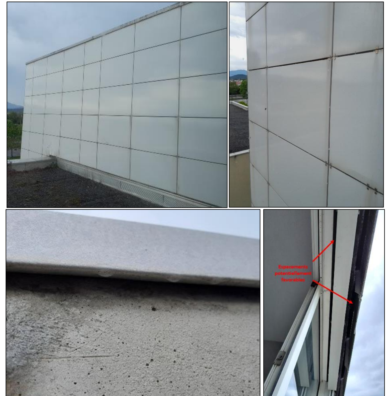
Figure 10 : Espacements entre les bardages (en haut) et au niveau des replis de couvertines (en bas à gauche) et espacements au niveau des fenêtres et des couvertines au-dessus de ces dernières (en bas à droite)
