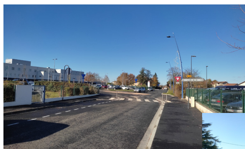
Aménagement de l'Avenue de Saint Plancard
