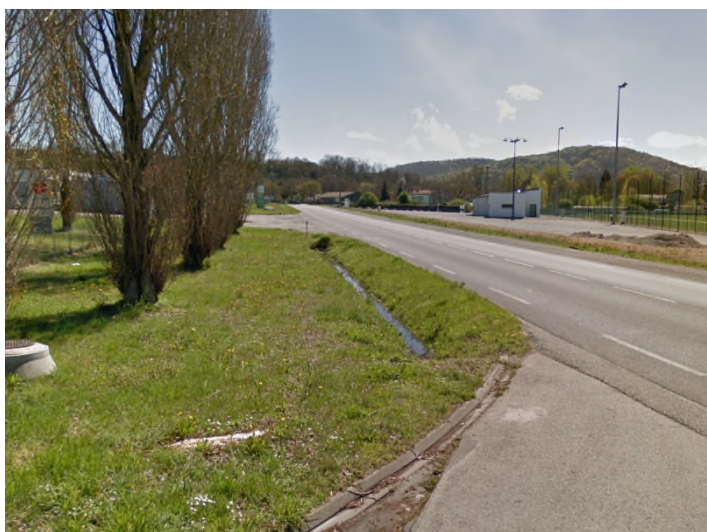
Figure 24 : Ouvrage de gestion des eaux pluviales existant
