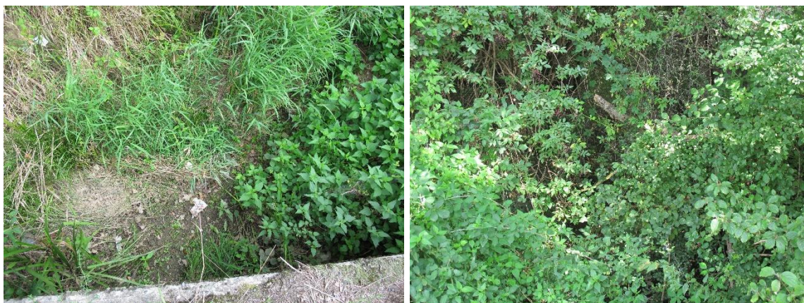
Ruisseau de la Baraille au nord de la ZAC, vers le parc des exposition – même ruisseau à l'est à proximité de la voie de la Chapelle (août 2019)
