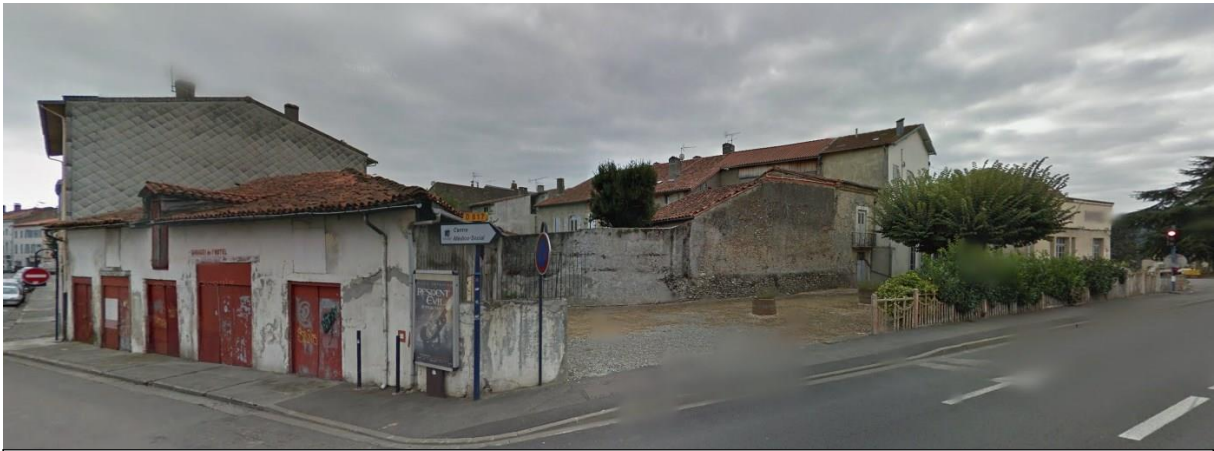
Ilot bâti dégradé, voire vétuste situé le long du Boulevard Louis Pasteur
