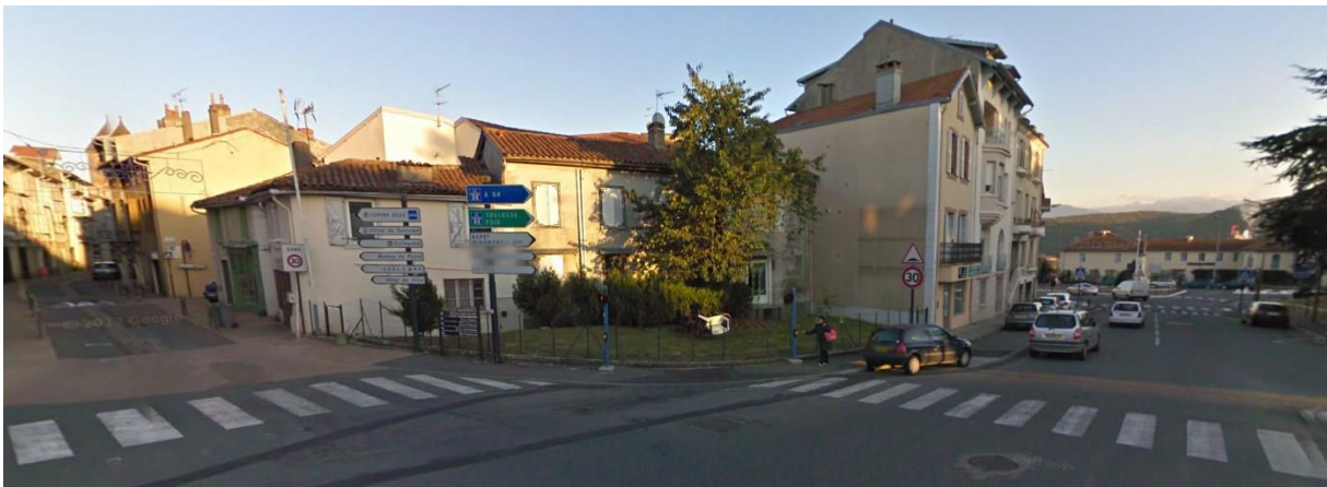
Ilot bâti non valorisé situé en entrée de ville Est, à la jonction entre le Boulevard Eugène Azémar et la Rue Victor Hugo
